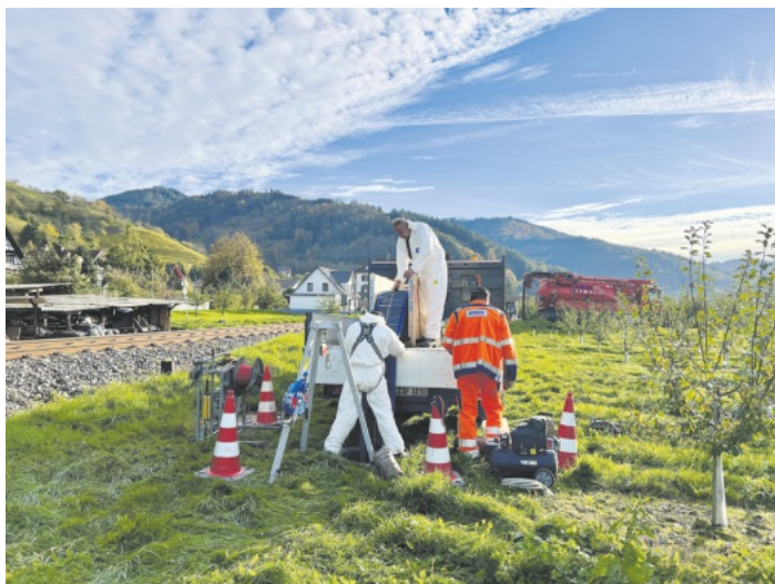
Einführung der Schlauchliner in den Schacht
